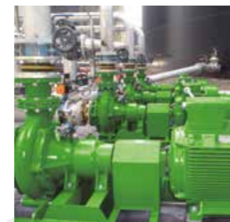
MAGNUM SX Bomba de materia densa, modelo con engranajes y soporte de cojinete
